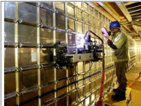
[선박 내 배관 용접부 검사]
